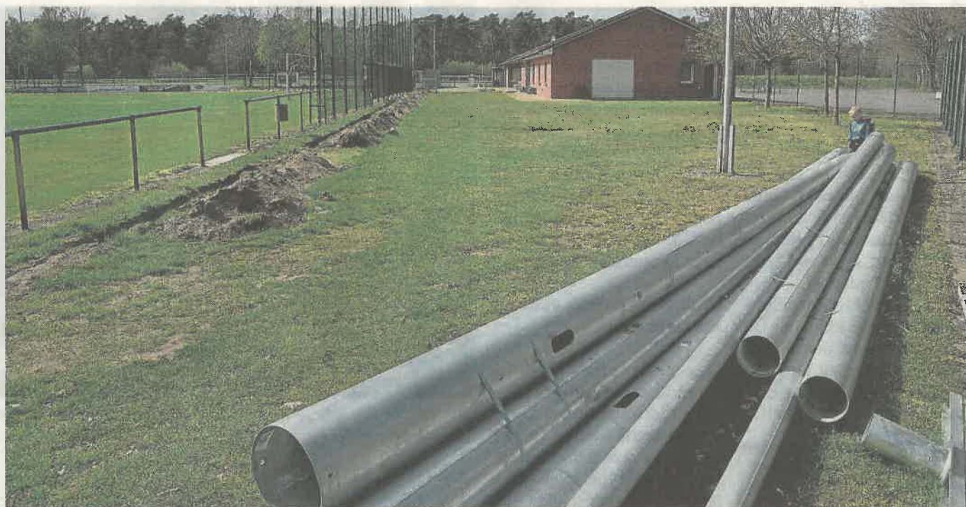
Bereit zur Montage: die neuen Flutlichtmasten in Halen.
