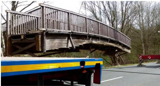
*Millimetergenau bugsiert der Kranlenker die Brücke auf den Auflieger.*
