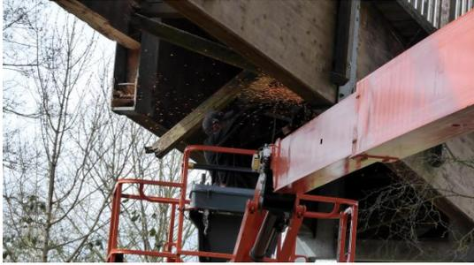
*Funken sprühen, als die Stahlschrauben abgeflex werden, damit das obere Brückenteil entnommen werden kann.*
